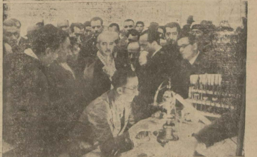
Üstte: Fabrikanın umumî görünüşü, Aittte: Davetlilerin önünde
